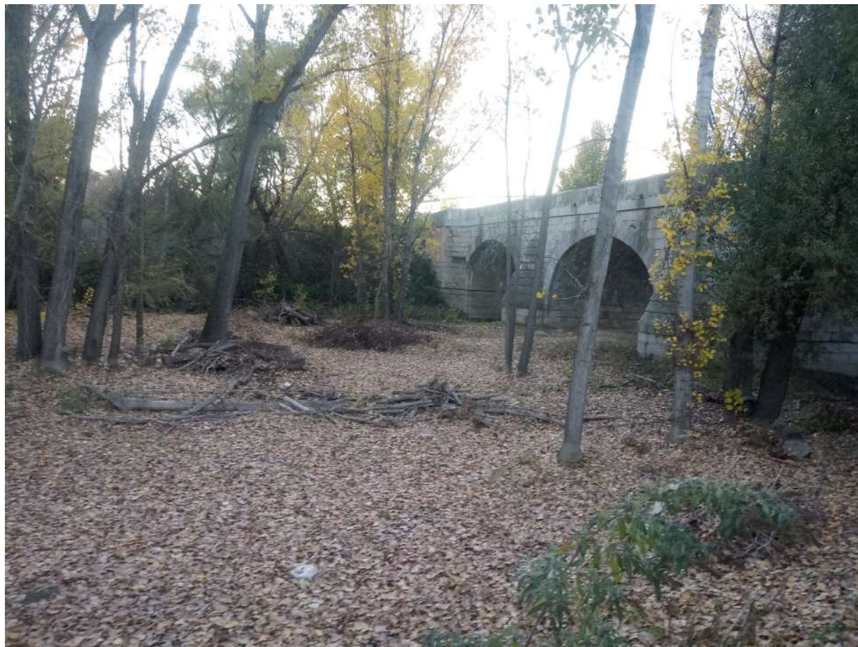
Puente de San Fernando
