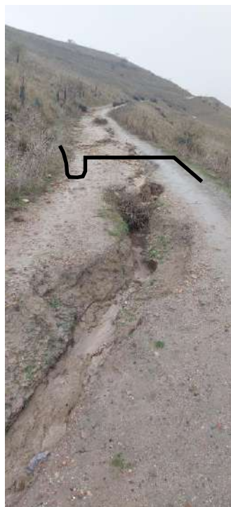
Tajea orientada hacia la cuneta interna o del desmonte
